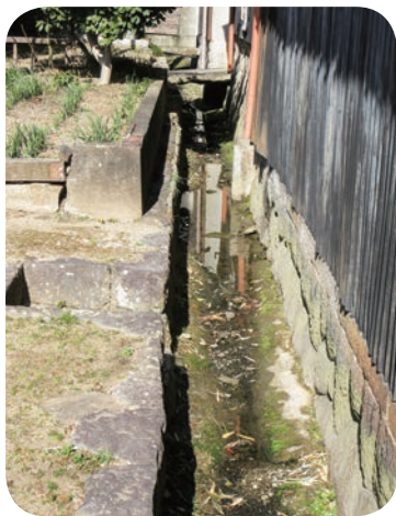
旧長谷川治郎兵衛家にある背割排水
